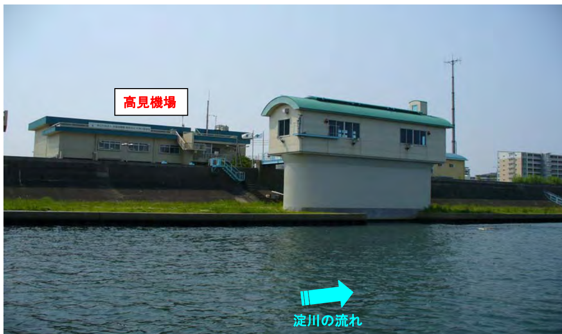
新淀川より、高見機場の取水口を望む
