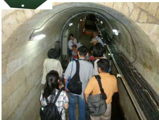
（室生ダム内部の痛廊）
