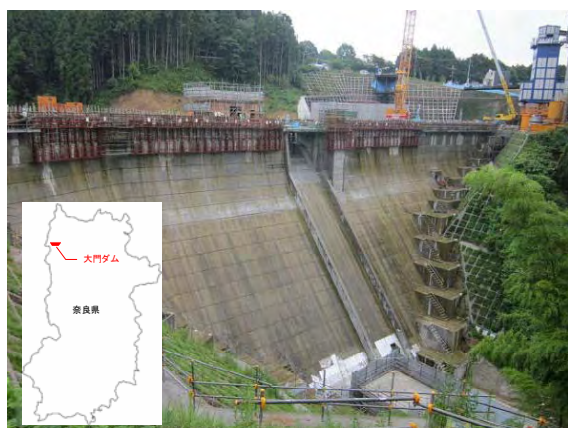
大門口ダム全景
